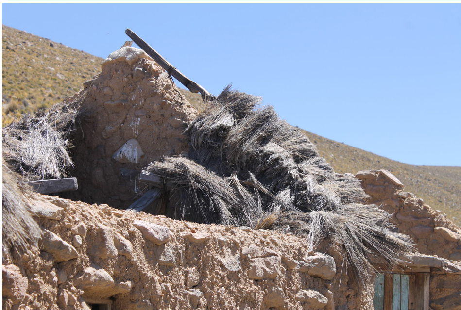
Acercamiento al techo de construcción tradicional. Registro personal.
