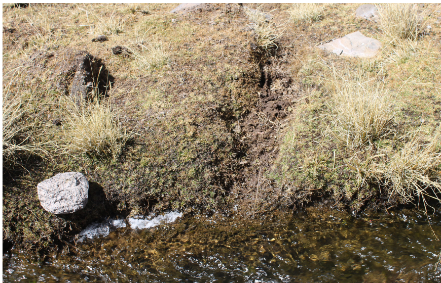
Acercamiento a uno de los canales por los que ya no entra el agua de la acequia. Registro personal.
