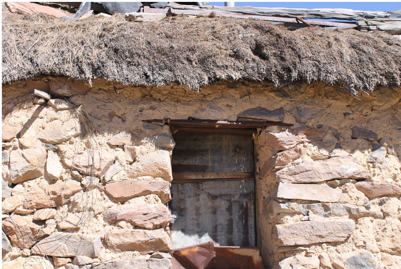
Pared frontal de construcción tradicional: casa con techo de paja brava. Registro personal.
