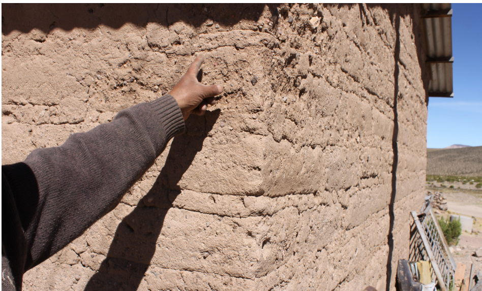
Don Jorge Quelca muestra una construcción tradicional donde se alcanza a ver la paja entre el adobe. Registro personal.
