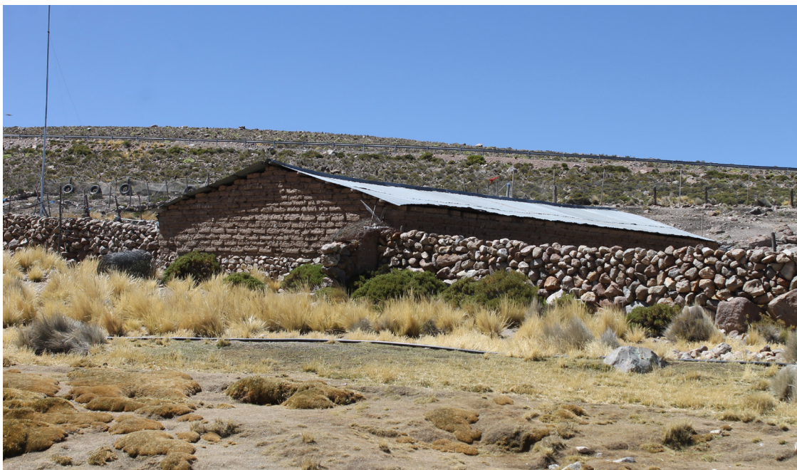
Corral techado construido durante la presidencia de don Jorge Quelca de la junta vecinal de Ancolacane. Registro personal.
