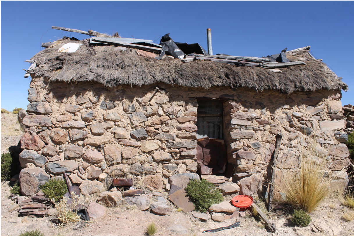
Vista general de construcción tradicional: casa con techo de paja brava. Registro personal.
