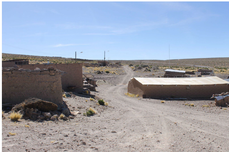
Vista de Chapoco hacia la carretera. Registro personal.
