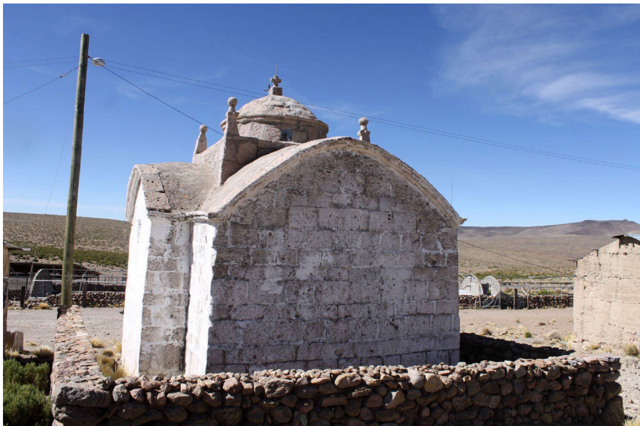
Pared posterior de la Iglesia de Chapoco. Registro personal.
