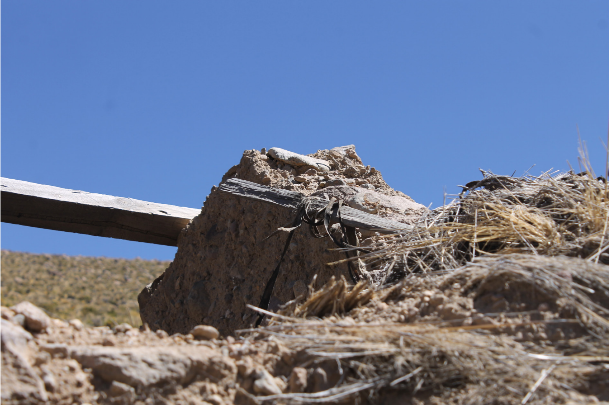
Detalle de los lazos de una construcción tradicional (hechos de cuero). Registro personal.
