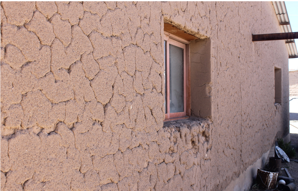
Muro de adobe estucado -y lavado por la lluvia- desde otro ángulo. Registro personal.
