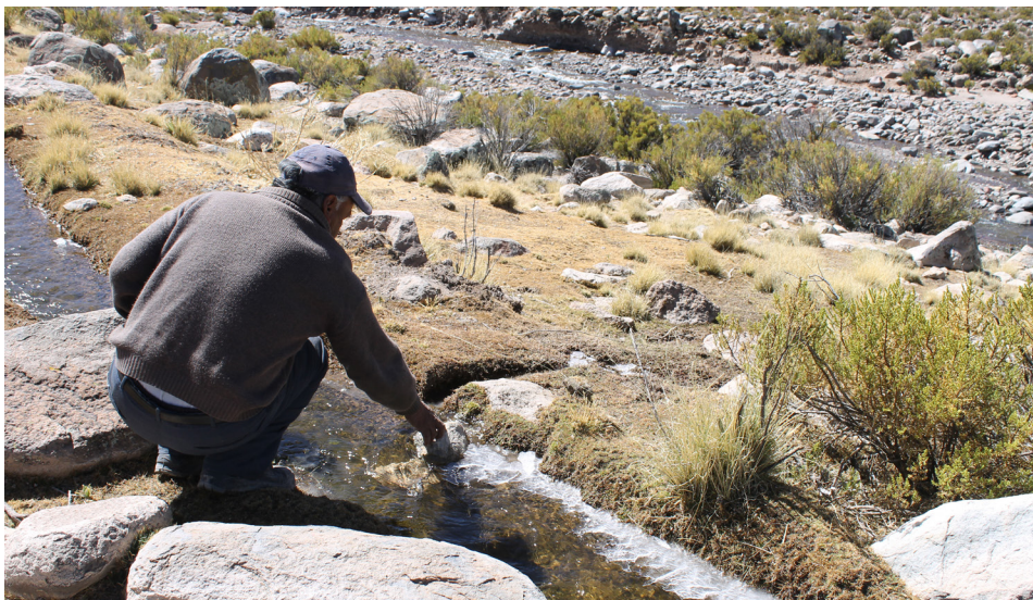
Don Jorge Quelca pone una piedra en el caudal principal de la acequia para alimentar uno de los canales por los que ya no entra el agua. Registro personal.
