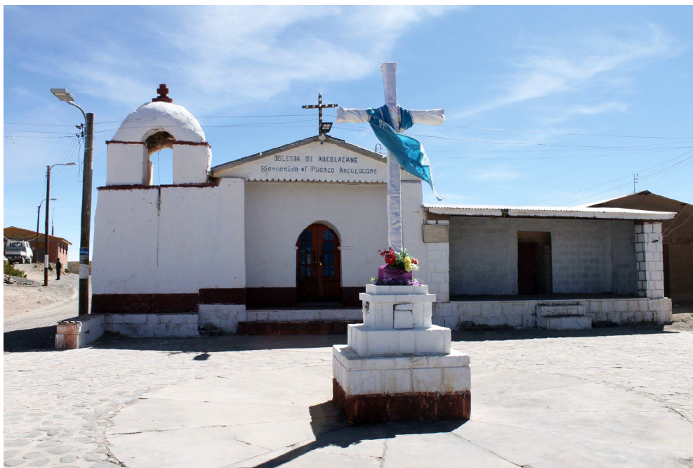
Frontis de la Iglesia de Ancolacane. Registro personal.
