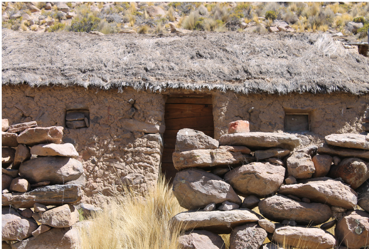
Acercamiento a pared y techo de construcción tradicional, estancia de don Cipriano Chura Silvestre. Registro personal.
