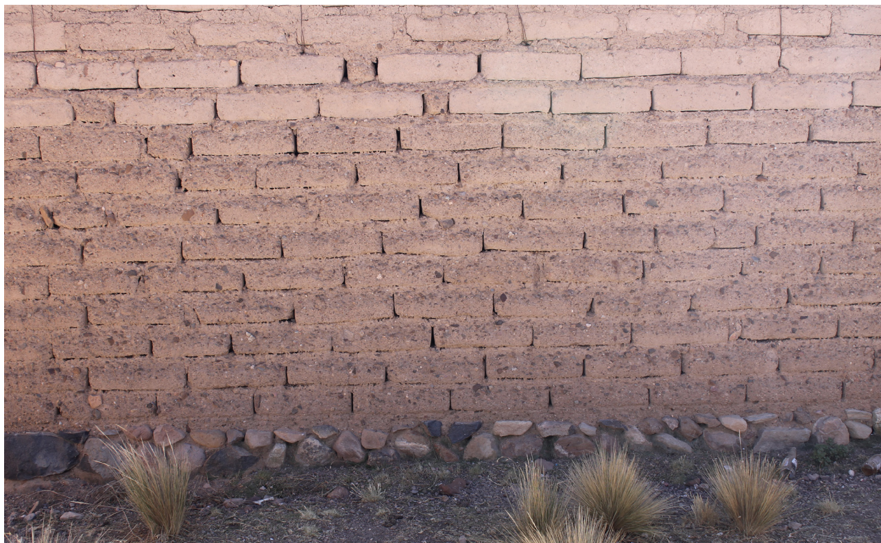
Muro de adobe sin estucar. Registro personal.
