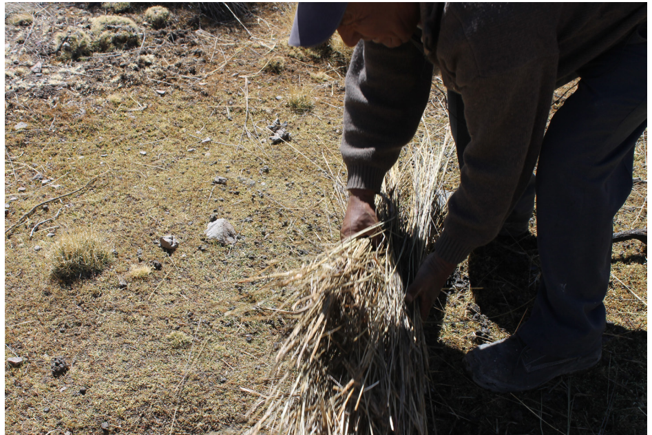
Don Jorge Quelca tomando el montón de paja brava escarmenada, humedecida y agrupada para mostrar cómo, una vez trabajada, se ponía en el techo de la casa. Registro personal.
