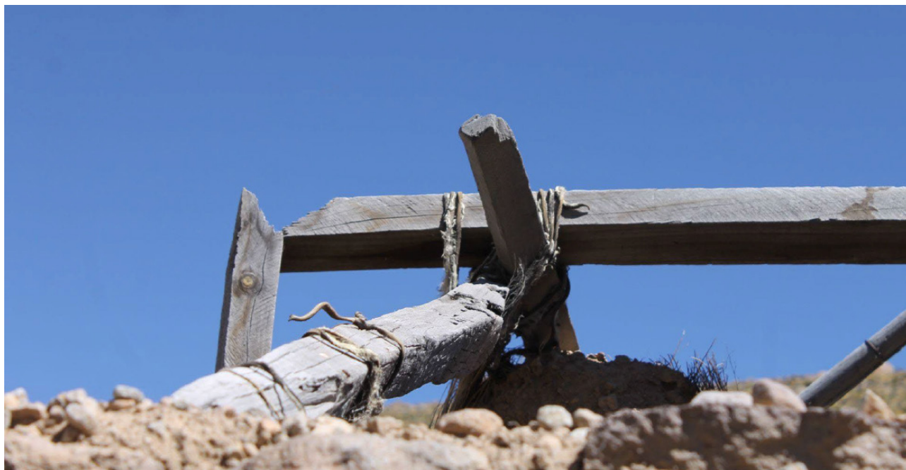
Acercamiento al amarre de una construcción tradicional. Registro personal.
