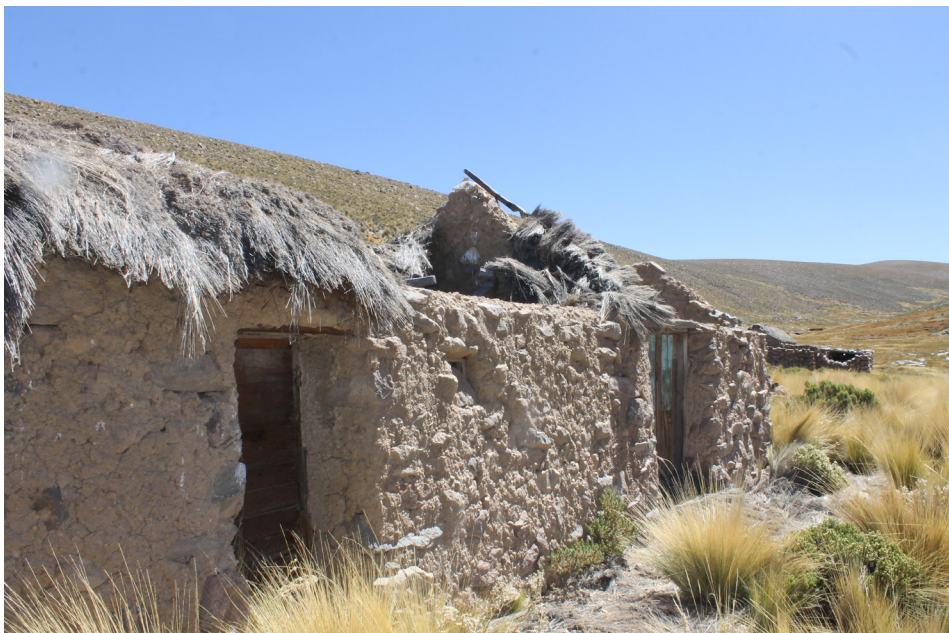
Acercamiento a pared y techo de construcción tradicional. Registro personal.
