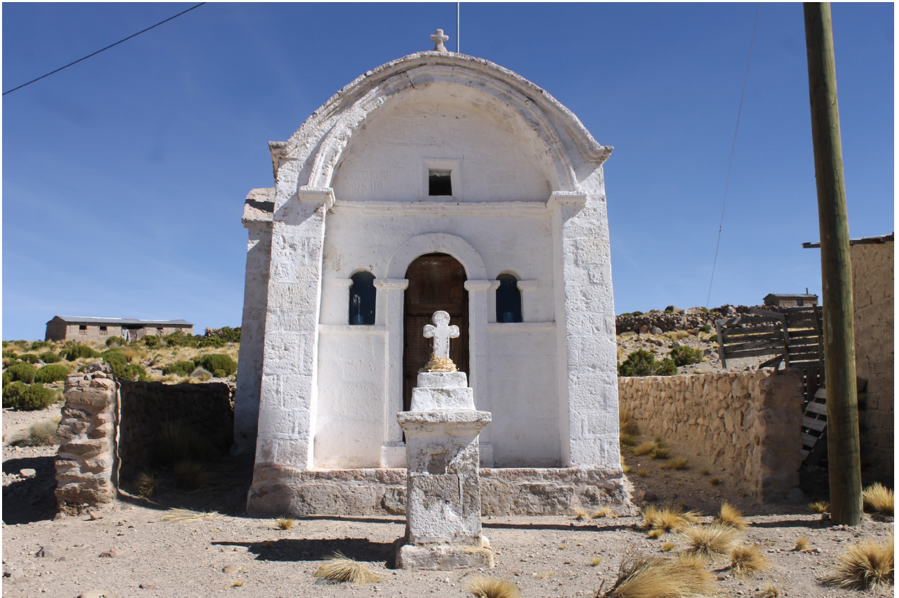
Frontis de la Iglesia de Chapoco. Registro personal.
