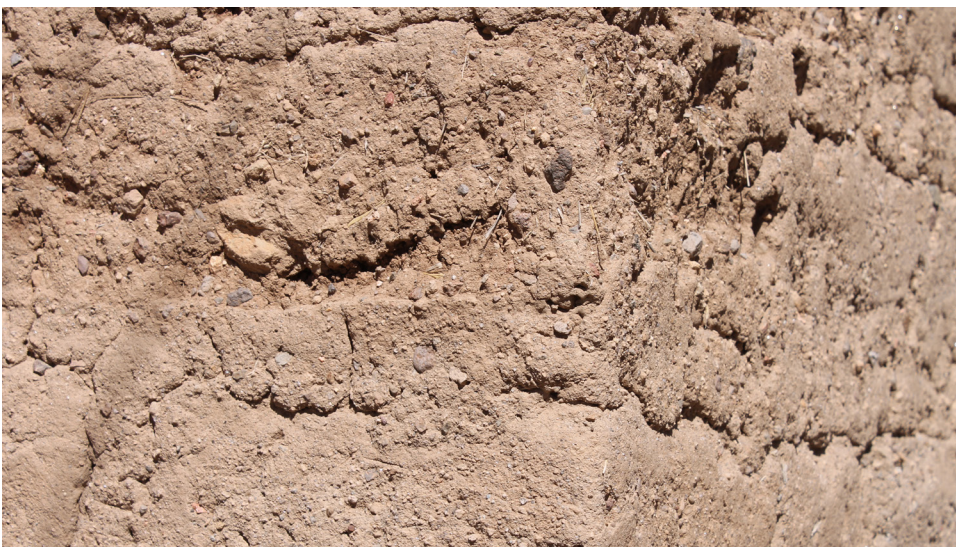
Acercamiento a una pared de adobe donde se puede apreciar la presencia de sicuya, partículas de arena y pequeñas piedras. Registro personal.
